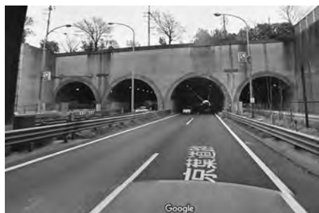
写真1 京葉道路貝塚トンネル
