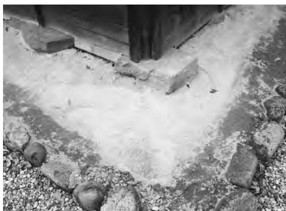
図6 モルタルの露出（母屋）
