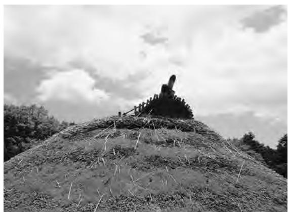
図7 茅葺屋根のずれ（中門）
