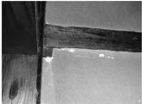
図3 ちりぎわの亀裂（母屋）
