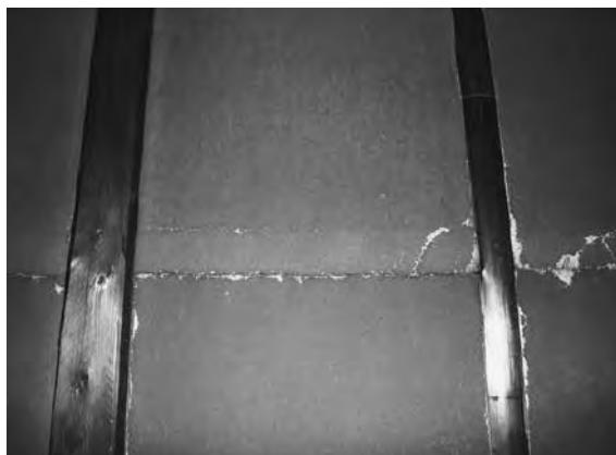
図4 貫部分の亀裂（母屋）
