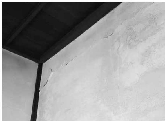
図5 漆喰壁の亀裂（母屋）
