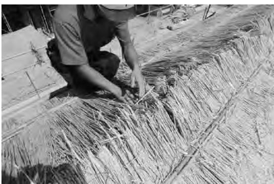
⑤ 棟の方向に茅束を敷き込んで繩で固定した。棟仕舞は、アスファルトルーフィングを100mm程度重ね合わせてかぶせ、その上に杉皮を敷いた。杉皮はまず棟方向に敷き、その上に棟と直交する方向に敷き込んだ。
