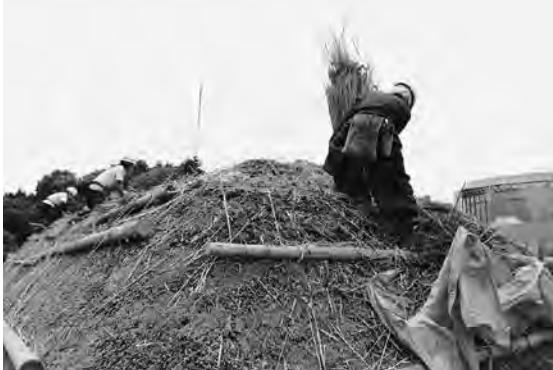
③ 棟下1m程度解体した箇所から平葺ひらぶきを行った。新規の茅を両側から厚みが均一になるようやなかに調整して重ね、押鉢竹と屋中竹で挟み込むようにして繩で固定した。
