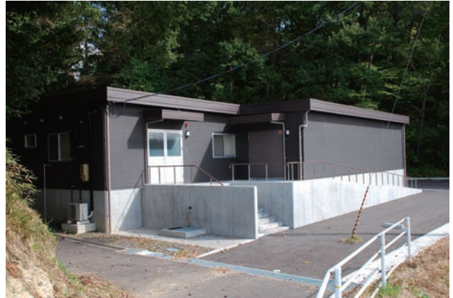
写真 15-5 被災ミュージアム再興事業によって建設された仮設収蔵庫
