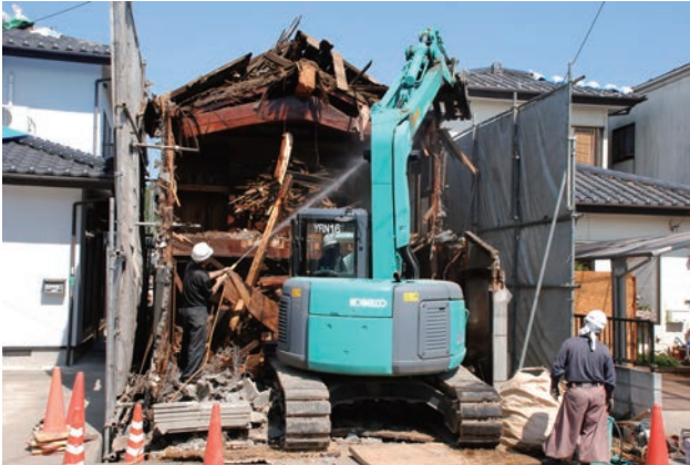
写真 15-1 解体される商家（2011 年 5 月 18 日）
