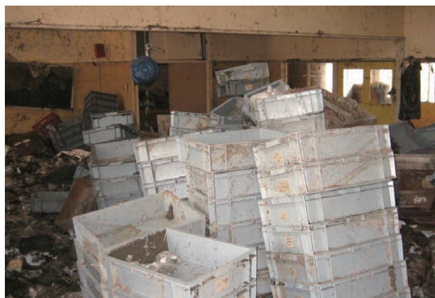
写真 26-1 野蒜文化財収蔵庫の被災状況
