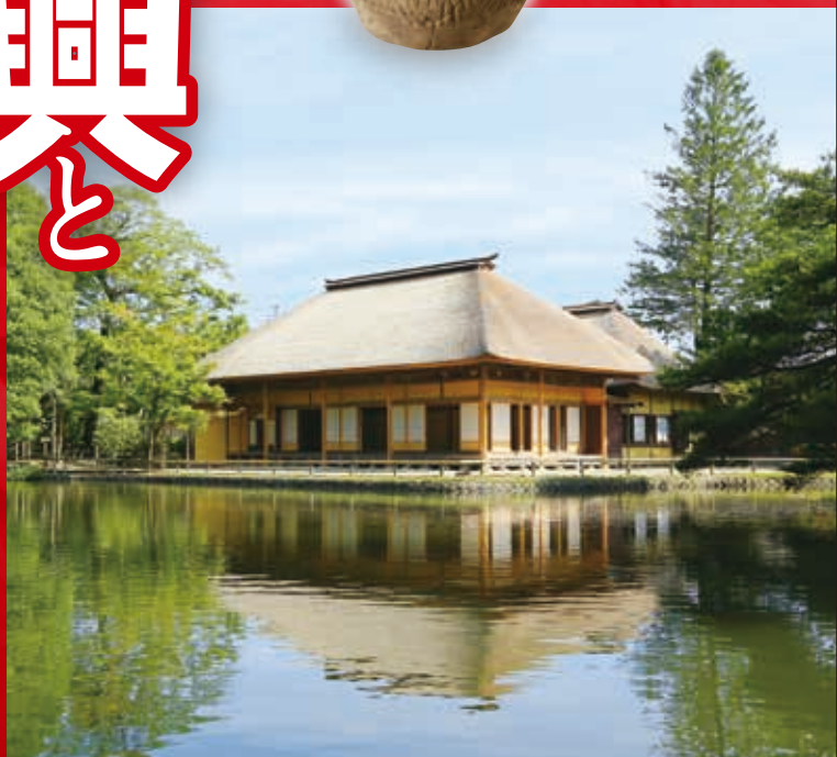
震災後に復旧された大崎市旧有備館及び庭園 御改所及び附属屋 大崎市教育委員会提供
