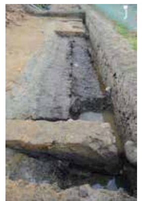
▲ 北側の材木列 (東から) 土留めとして使われました。
