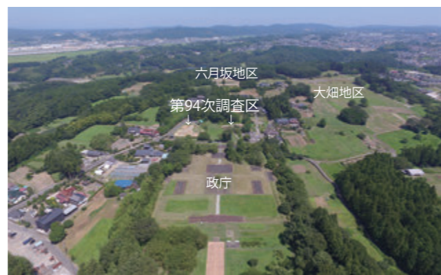
写真1 第94次調査区遠景(南から)
