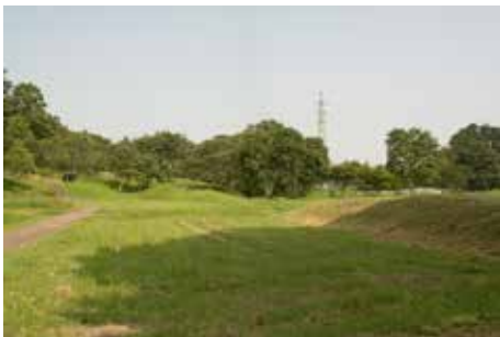
盛土養生した 築地塀跡 (南辺東側)
