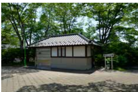
トイレ (多賀城廃寺跡)
