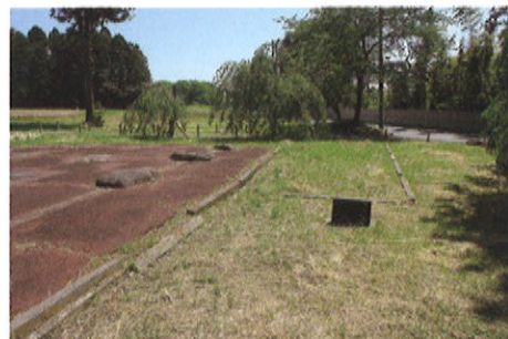
建物の 重複表示と その劣化 (六月坂地区)
