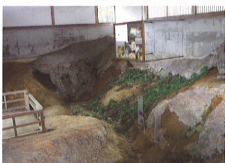
空堀露出展示の劣化 (平成26年撮影)
