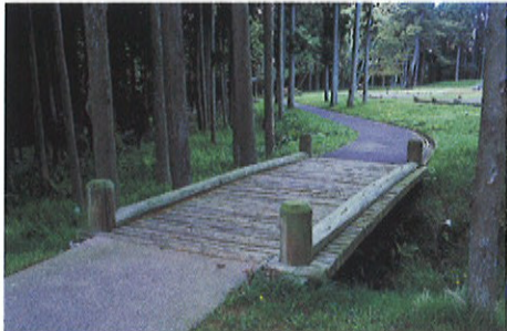
空堀跡にかけた橋
