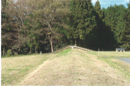
盛土整形した 東辺築地 (平成 26 年撮影)
