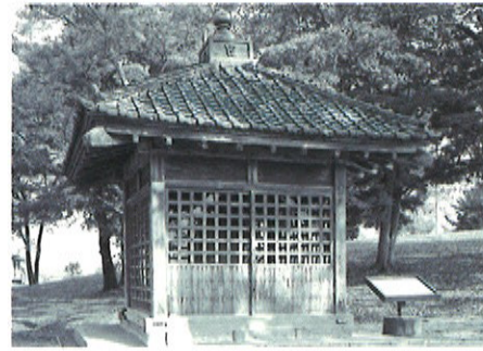
修理前の覆屋
