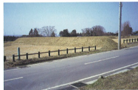
東辺築地塀 盛土整形
