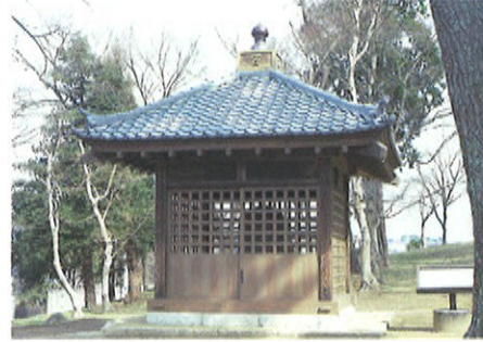
修理後の覆屋
