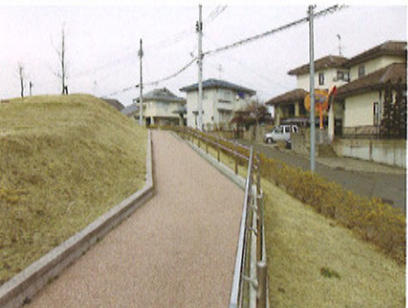
園路と 手すり
