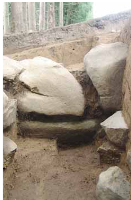
SX2920 石垣 (南から)
