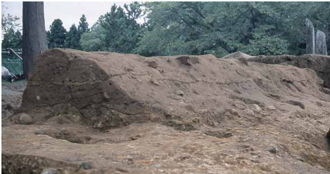
SF167 北辺築地堀跡（北東から）
