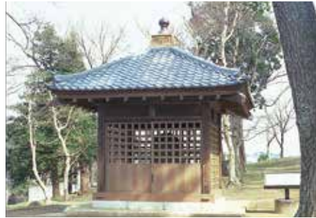
修理後の覆屋
