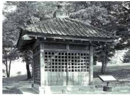
修理前の覆屋
