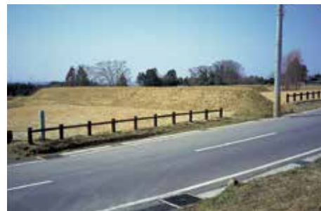
東辺築地堀 盛土整形
