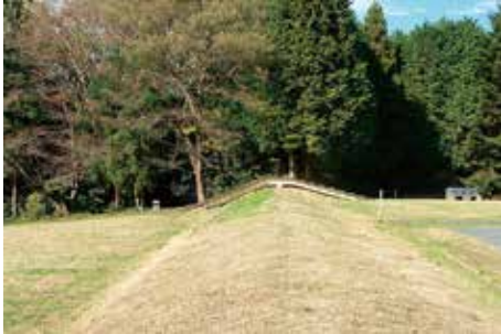
盛土整形した 東辺築地 (平成26年撮影)
