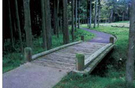
空堀跡にかけた橋
