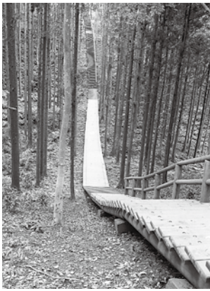
斜面に設置した木道
