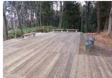
園路終点のデッキ (再整備)
