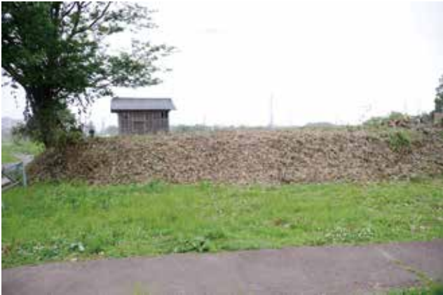
調査前状況 (北から)
