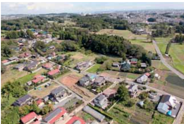
第84次調査（南西から）
