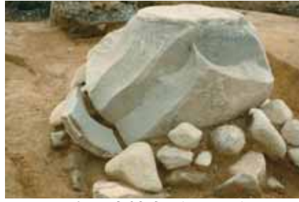
左写真拡大（北から） 〔中央柱間礎石の割れと接合〕
