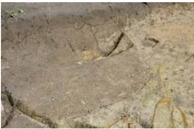
SK3100 と SB3077 (南西から)
