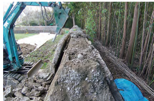
コンクリート築地塀撤去作業
