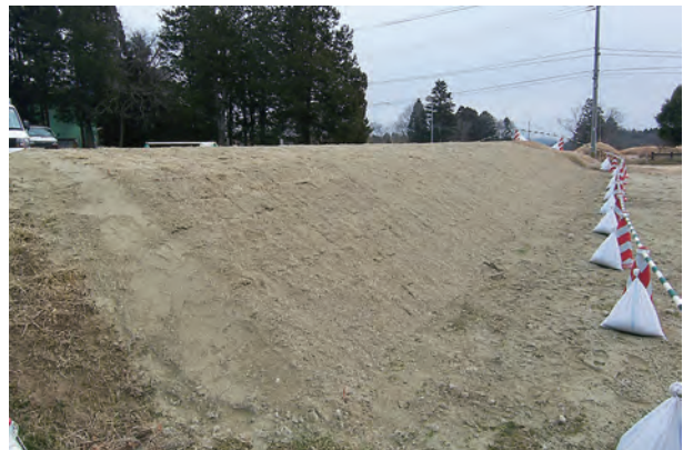
築地盛土整形・貼芝工
