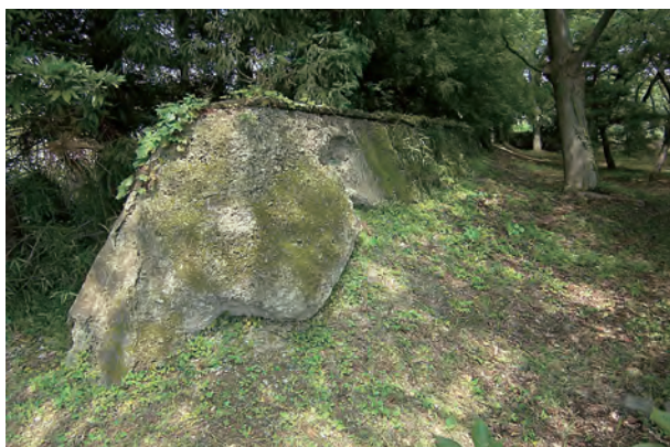
崩壊の進んだコンクリート築地塀
