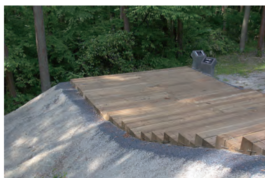
オーバーデッキ撤去後の枕木階段設置
