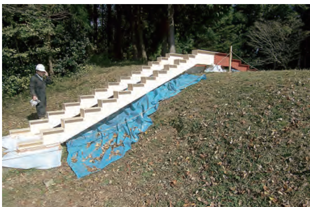
オーバーデッキの改修
