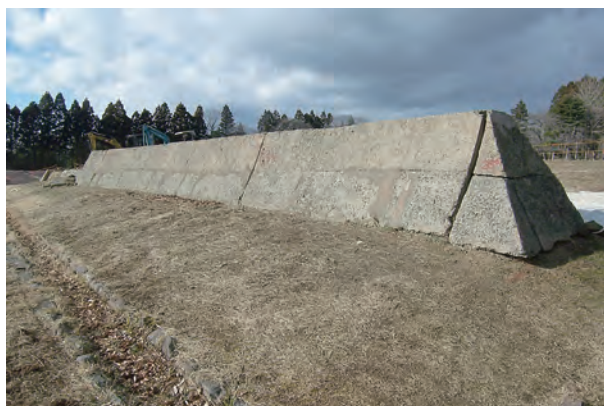
撤去前のコンクリート整形の築地塀
