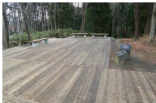
枕木舗装・ベンチ設置
