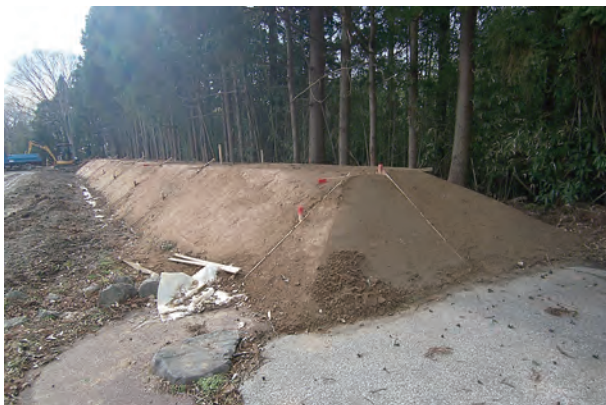
仮盛土工（法勾配1：1.5）
