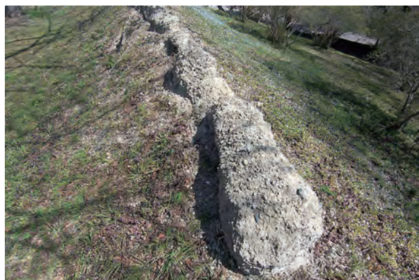
崩壊の進んだコンクリート築地塀
