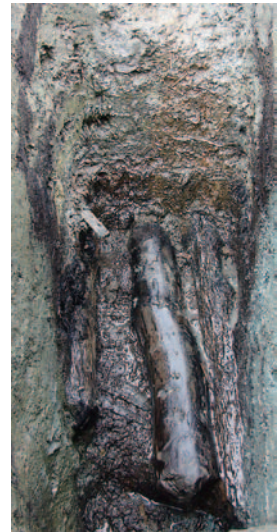
断ち割り部の筏地業 (東側)
