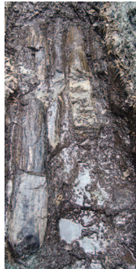
断ち割り部の筏地業 (西側)
