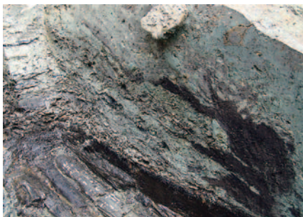
西側断ち割り断面 (南西から)
