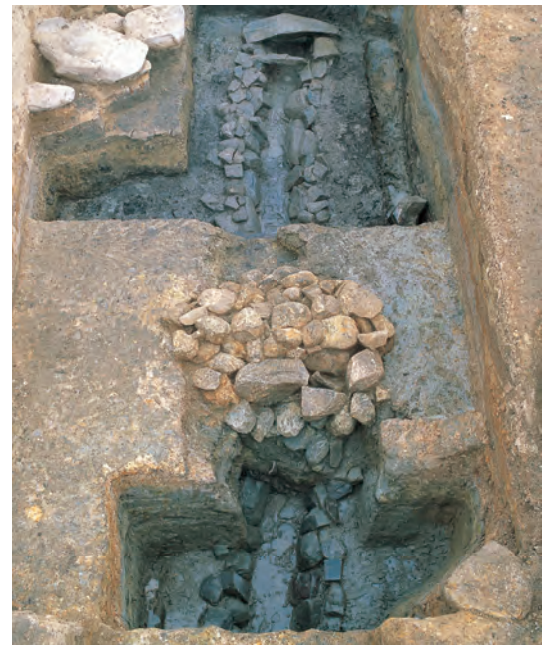
道路につくられた暗渠排水施設
