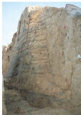
築地塀断面 土を何層にも突き固めている。
