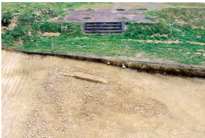
東門付近の道路舗装 東門から城内へ入ったすぐの場所には、石や瓦の破片を敷き詰めた舗装路面が残る。斜面下方にあたる道路の南側には排水のための側溝が付く。
