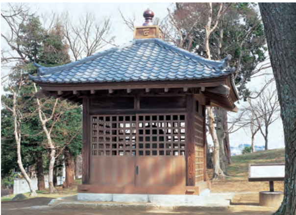
多賀城碑覆屋 仙台伊達藩四代藩主伊達綱村の時に(1700年前後)、水戸藩主徳川光圀(水戸黄門として有名)の勧めで建築した。写真は1875年に建て替えられ、1998年に解体修理されたもの。
