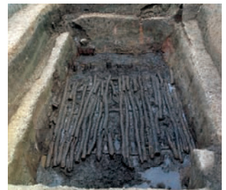
塀の基礎工事 低湿地では、沈下防止のために丸太材を筏状に組み合わせた塀の基礎工事が行われている。
